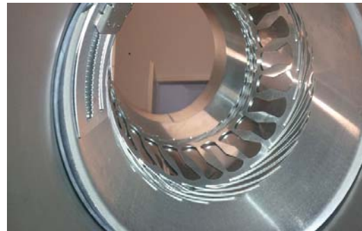
Pipe-Seal-Flex Edelstahlhülse installiert in Achsabweichung und Rohrversatz
