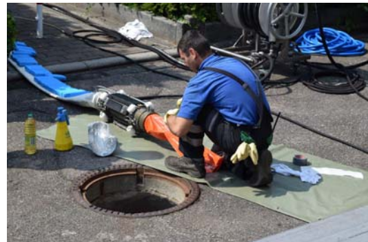
STREET TO HOME® Pneumatische Setzeinheit mit Fahrwagen (IBG HydroTech GmbH)
